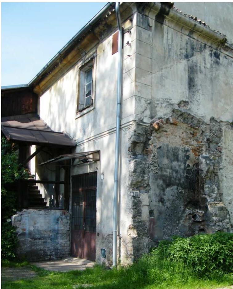
V sousedství domu sládka stávala kovárna.
